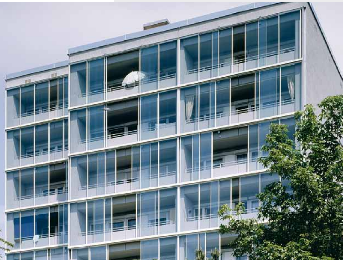
Das Schiebesystem Aweso Euroform® ISO 90/24, für 24 mm Isolierglas, möglich in 2- und 3-bahniger Ausführung.
